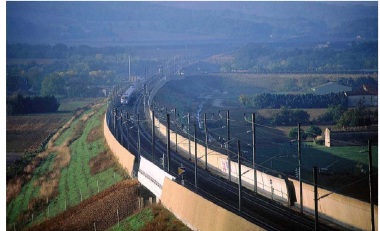
Figure 11 : exemple de protection acoustique à la source : écrans.
